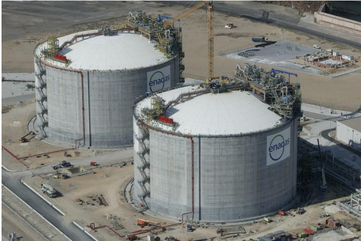
2In the wall Tanks PC 150.000m 3 El Musel
